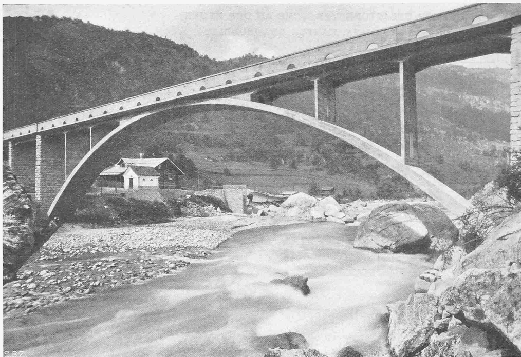
Abb. 2. Die neue Rheinbrücke bei Tavanasa, schräg flussabwärts gesehen.
